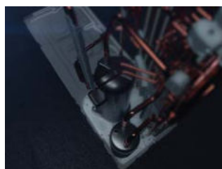
Kompresor s dvojitým vstříkáváním pro chladivo R-32
